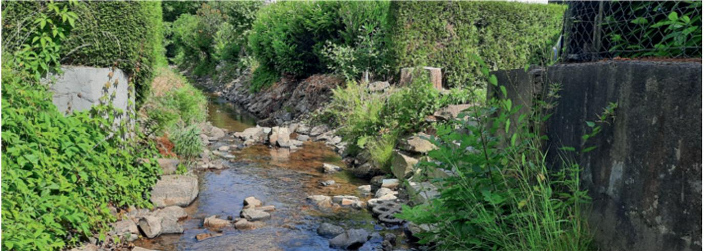
Abb. 14: Durch Ufermauern, steile Uferböschungen und zu dicht gepflanzte Heckenstrukturen eingeengter Bachlauf
