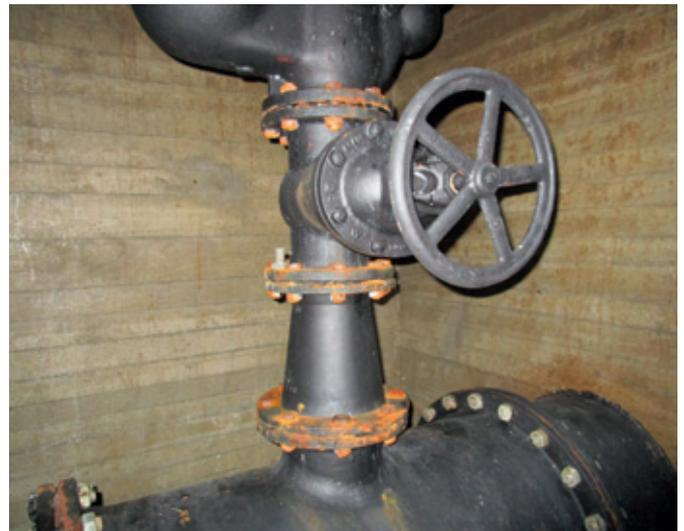
Abb. 86: Alte Armaturen am Hochpunkt Breitgen (Quelle: Aggerverband)
