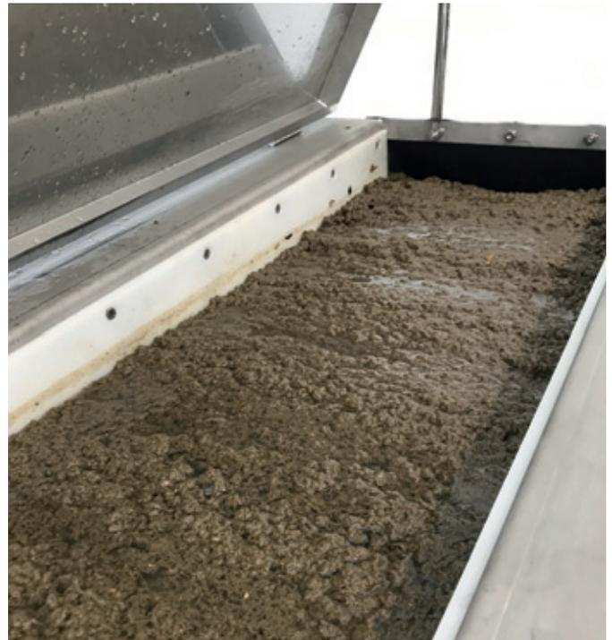
Abb. 27: Schlammkonzept eingedickter Schlamm Ovalplatteneindicker
