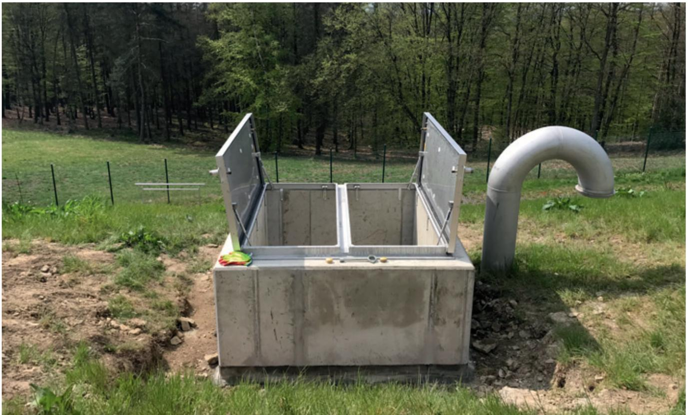
Abb. 89: Neue Montageöffnung mit herausnehmbarem Mittelsteg (Quelle: Aggerverband)
