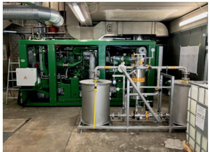
Abb. 26: Neubau BHKW KA Krummenohl mit Gasaufbereitung
