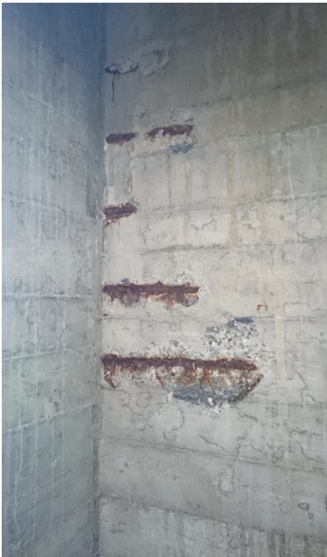
Abb. 87: Betonfehlstellen HPLützingen (Quelle: Aggerverband)
