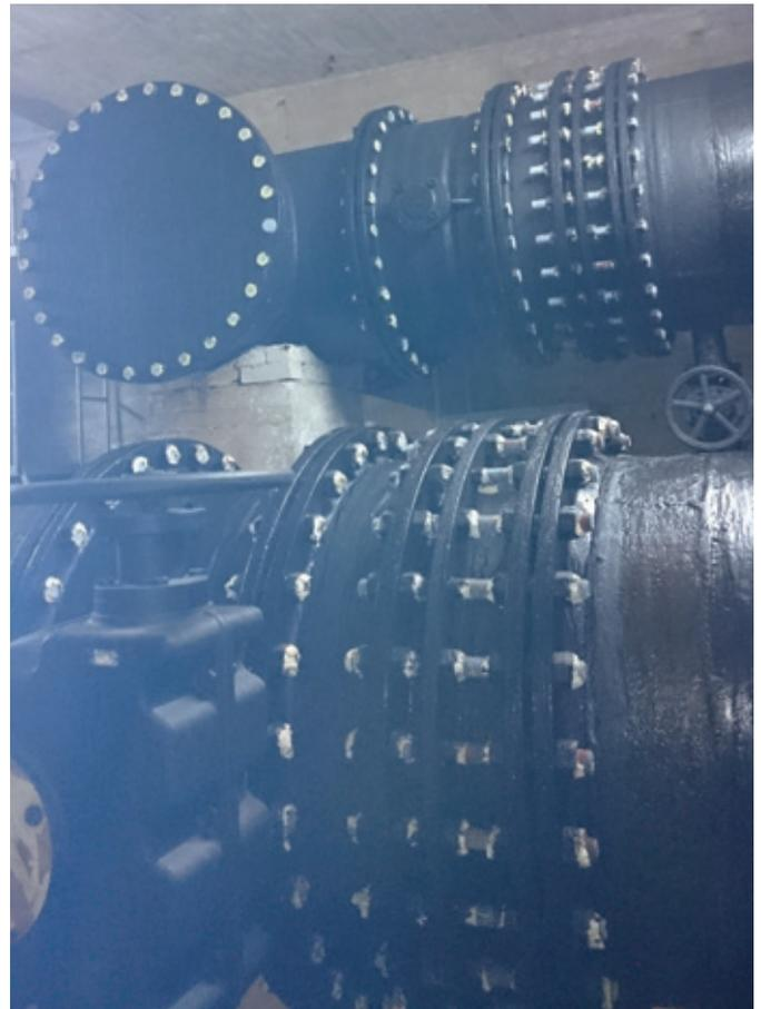
Abb. 91: VT 2, alte Absperrklappen und Ausbaustücke DN 1000 mm
