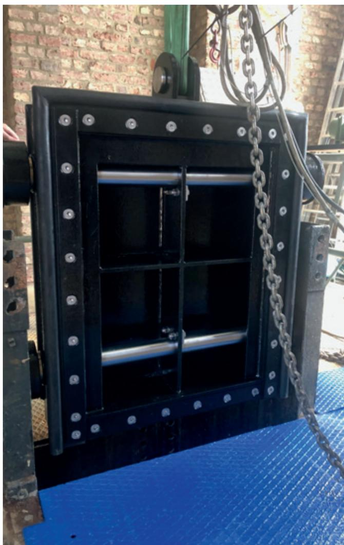
Abb. 21: Montage neues Rollschütz
