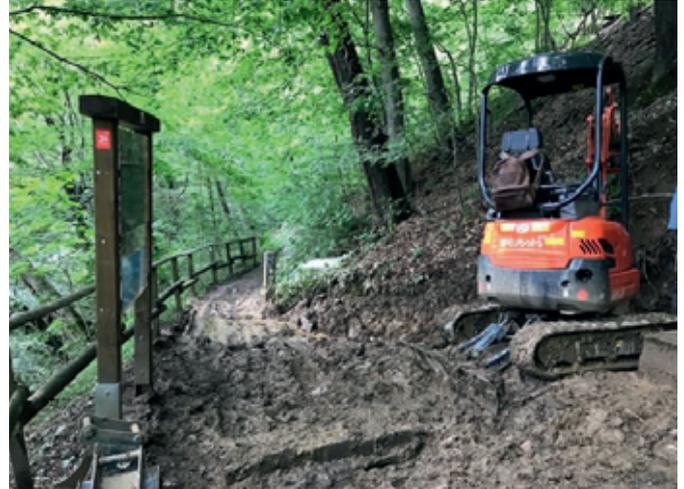
Abb. 93: Herstellen einer Zuwegung vor Rohrbruchreparatur (Quelle: Aggerverband)
