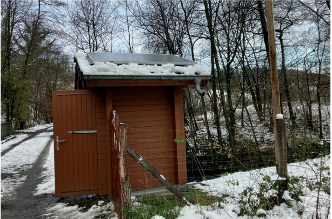
Abb. 18: Pegelhaus mit Photovoltaikmodulen zur Notstromversorgung (Quelle: Aggerverband, Stand 2024)
