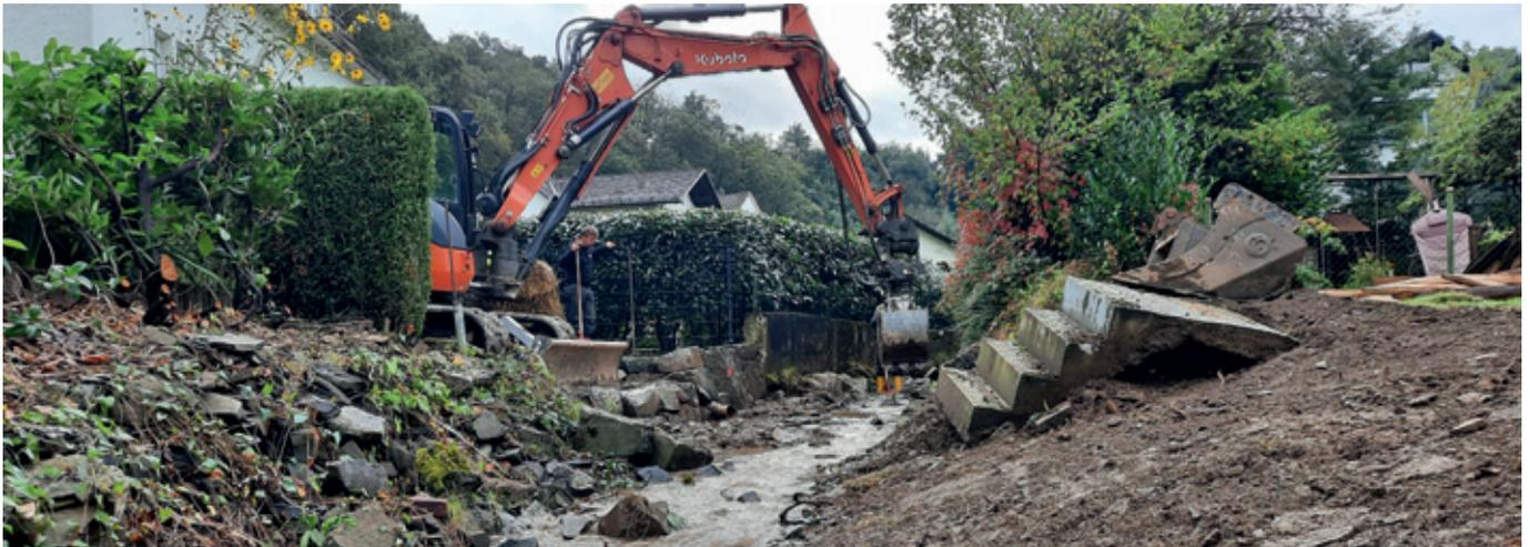
Abb. 15: Abrissarbeiten und Herstellung einer abgeflachten linksseitigen Uferböschung (Bild gegen die Fließrichtung aufgenommen)
