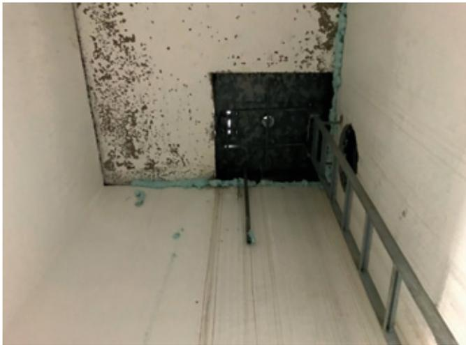
Abb. 90: VT 2, alte Einstiegsöffnung mit Schachtdeckel
