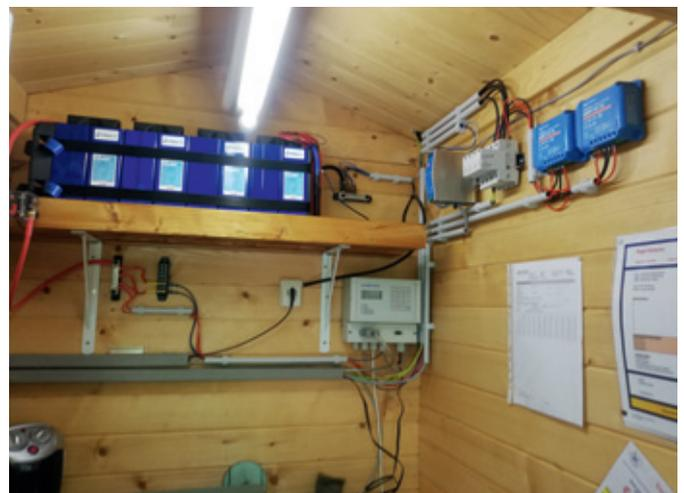
Abb. 19: Technische Ausstattung Pegelstation für die Notstromversorgung (Quelle: Aggerverband, Stand 2024)
