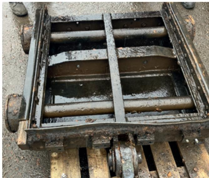
Abb. 20: Ausgebautes altes Rollschütz
